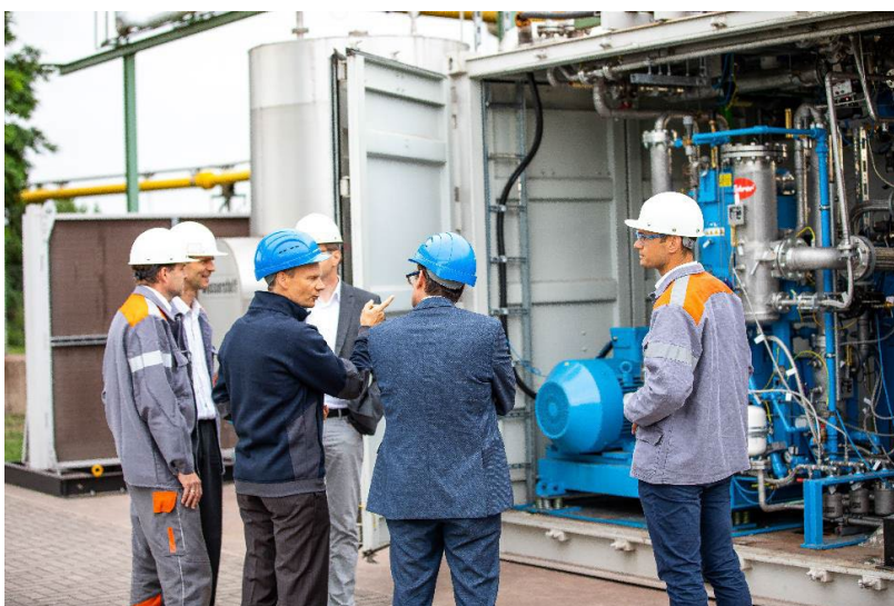
GrInHy2.0 Projektteam vor der Elektrolyse-Anlage im Stahlwerk Salzgitter (© Salzgitter AG)
